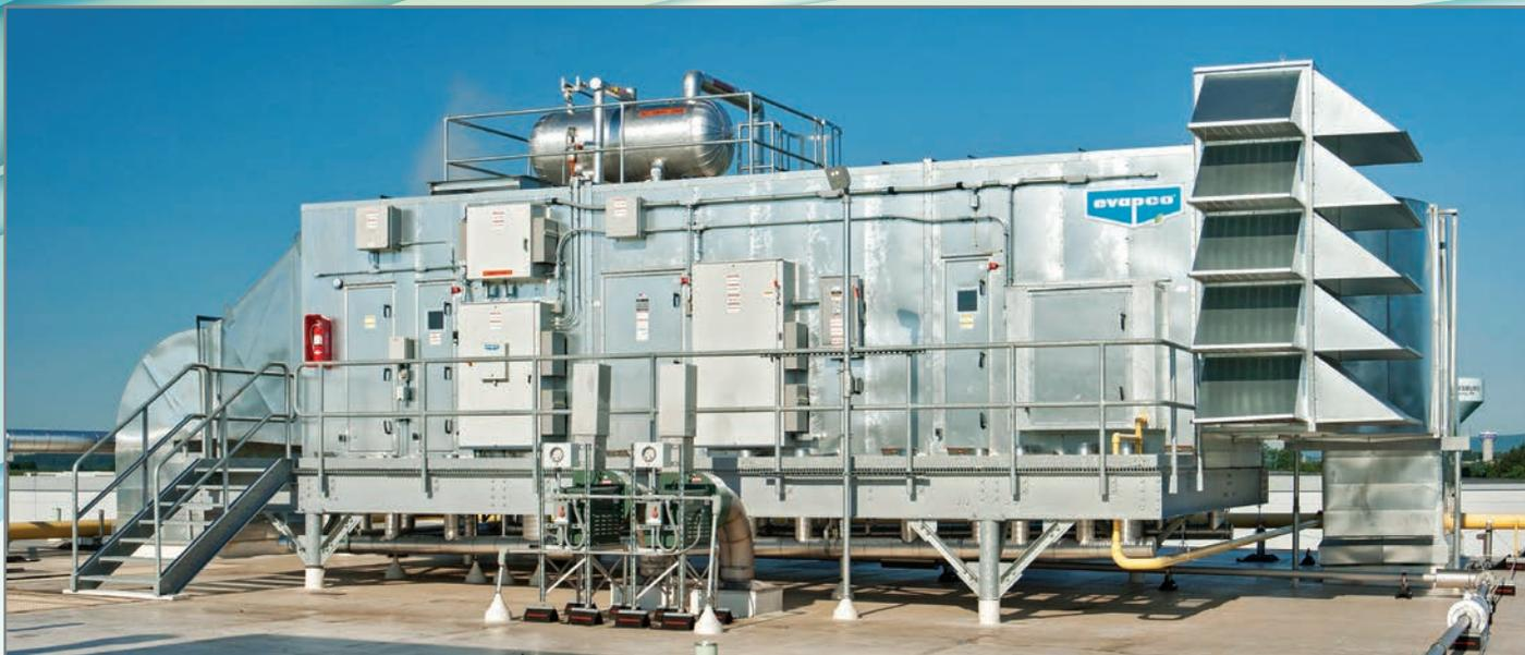
Critical Process Air (CPA) Приточно-Вытяжная установка Гигиенического типа
