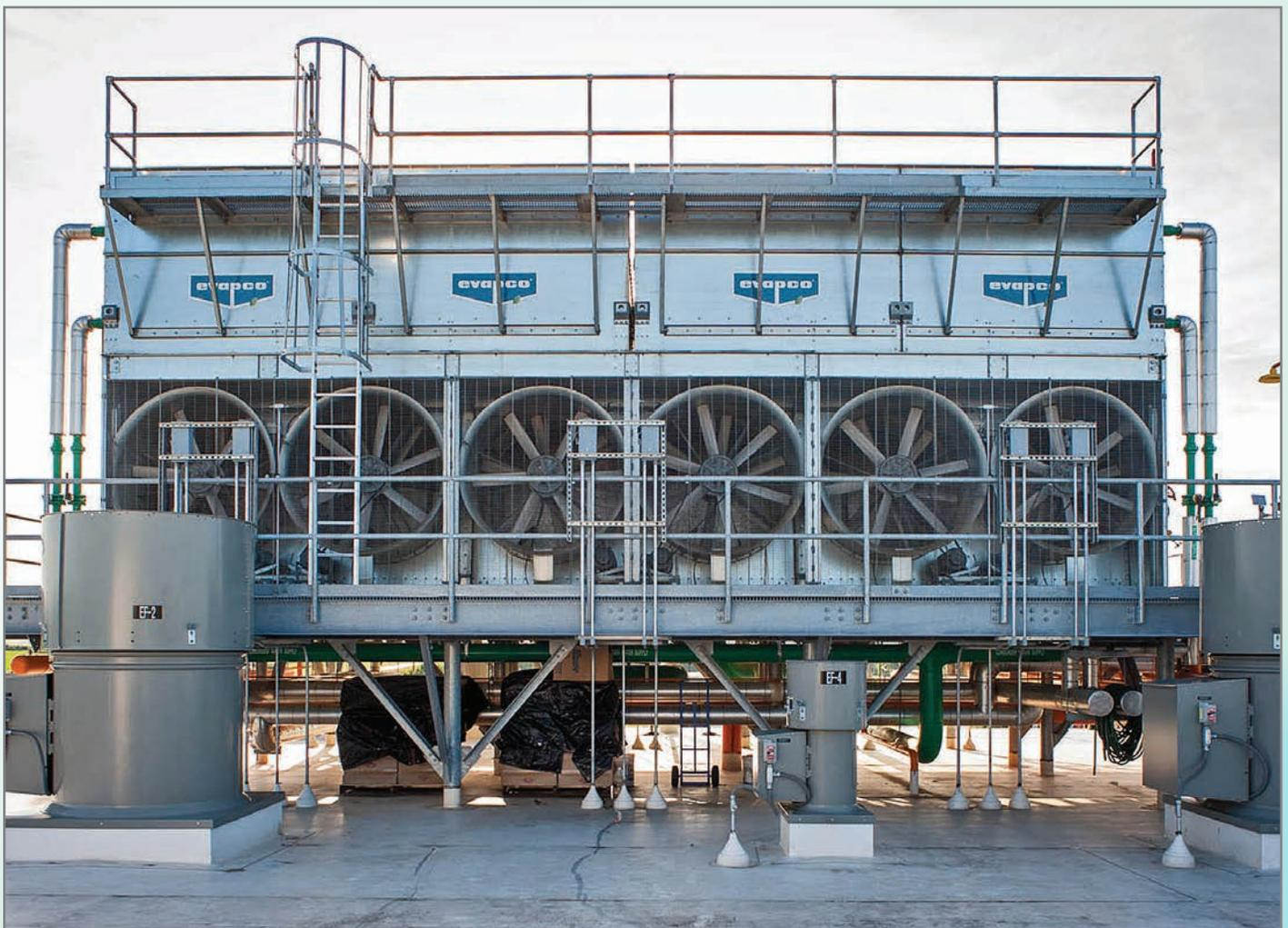
Испарительный конденсатор PMC-E с сервисной платформой.
