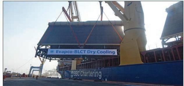
Транспортировка 250 тонного двух вентиляционного модуля
