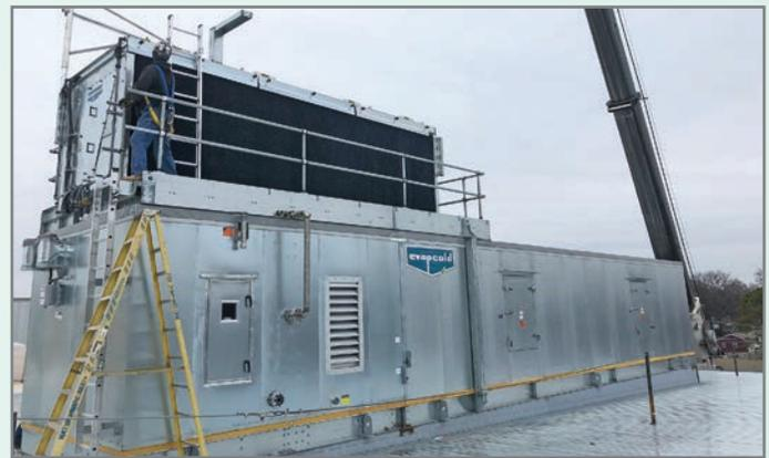
Evapcold Компактная холодильная система с низкой заправкой аммиака LCR-P-A
