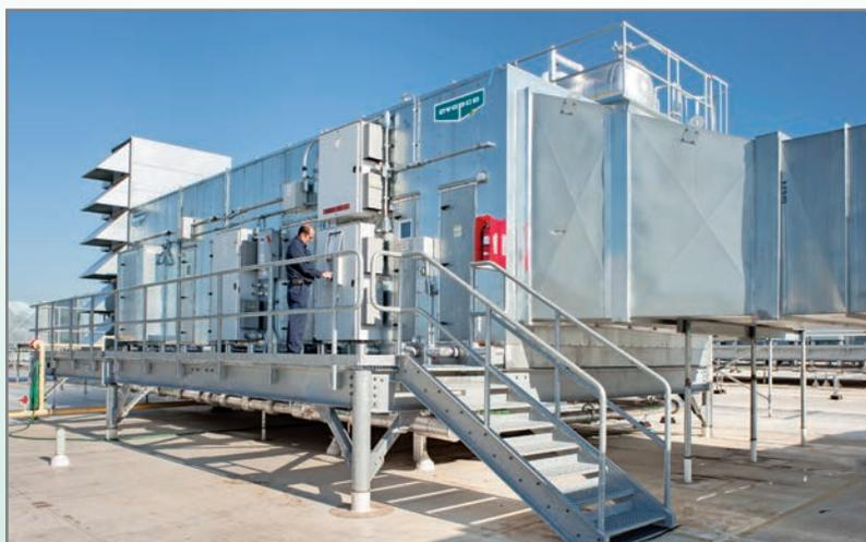
Critical Process Air (CPA) Приточно-Вытяжная установка Гигиенического типа
